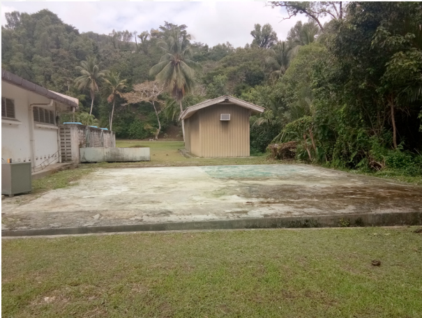
Selepas kerja-kerja meroboh selesai.
