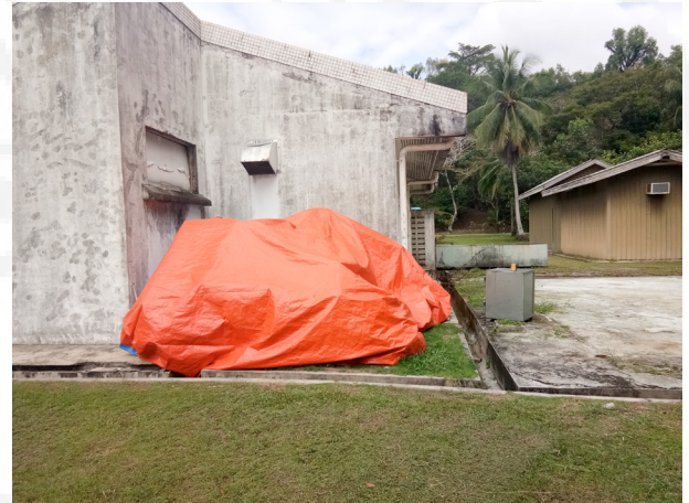
Barang perabot (kerusi, meja, dan almari) yang rosak disimpan sementara di luar kawasan stesen elektrik.
